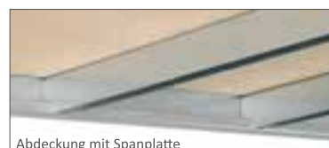
Abdeckung mit Spanplatte
